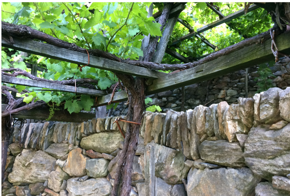
Figura 33: Pergola Valdostana alta: particolare dei muretti a secco e della tradizionale struttura in legno.
