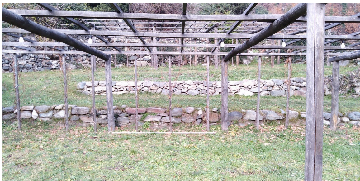
Figura 14: Particolare costruttivo della Pergola Valdostana alta, struttura verticale.
